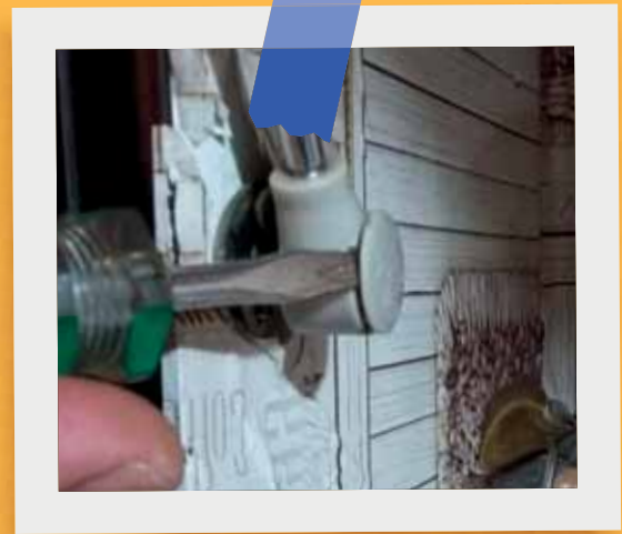
تا پایه آزاد شود و تنه را از پایه جدا کنید. اگر محل اتصال از نوع خاردار باشد (تصویر ۴)
